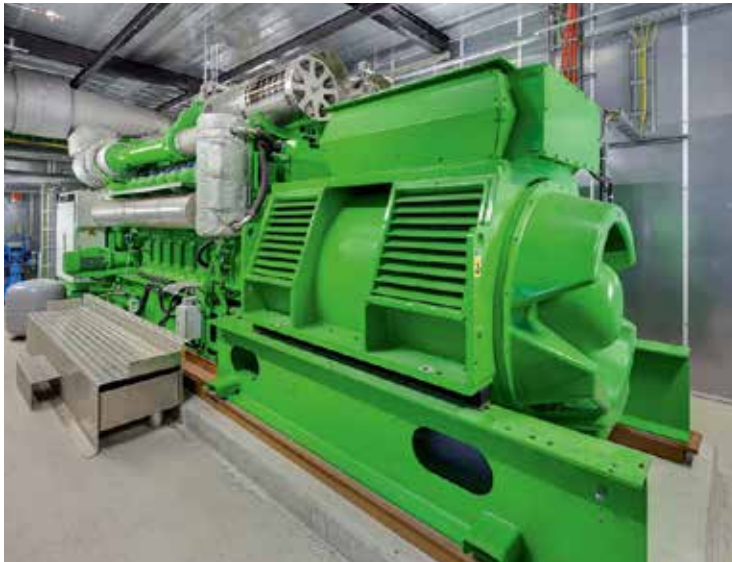
Ein zusätzliches Blockheizkraftwerk mit einer Leistung von 2,4 MW th und 2,6 MW el wird das Energiekonzept des Planungsbüros Gammel komplettieren.
