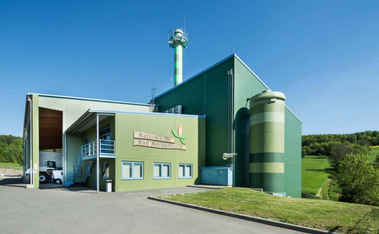
Klimafreundliches Heizkraftwerk in Bad Mergentheim: In ökologischer wie auch in ökonomischer Hinsicht stellt die Fernwärmeversorgung auf Basis von Holz für die baden-württembergische Kurstadt einen Gewinn dar. Im Jahr 2009 kam der Gedanke für dieses Konzept erstmals auf.
