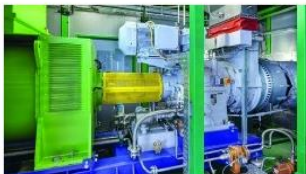
Abb. 5: Nach ausführlichen Berechnungen des Ingenieurbüros stellte sich eine Gasturbine mit einer Leistung von 1,6 MWel als wirtschaftlichste Variante heraus. Diese deckt circa 82 % des Jahreswärmebedarfs. © Gammel Engineering
