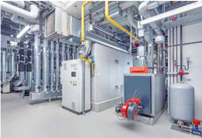
Ein Blockheizkraftwerk mit einer Leistung von 125 kW el und 184 kW th arbeitet nach dem Prinzip der Kraft-Wärme-Kopplung und stellt die benötigte Energie für verschiedene Prozesse im Unternehmen bereit.
