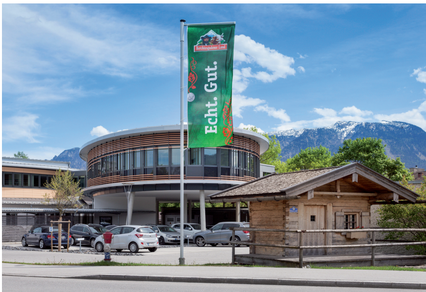
Bei den Milchwerken Berchtesgadener Land in Piding wurde eine neue Energiezentrale mit Erweiterungsmöglichkeiten installiert. Federführend bei der Planung und Ausführung war die Gammel Engineering GmbH.
