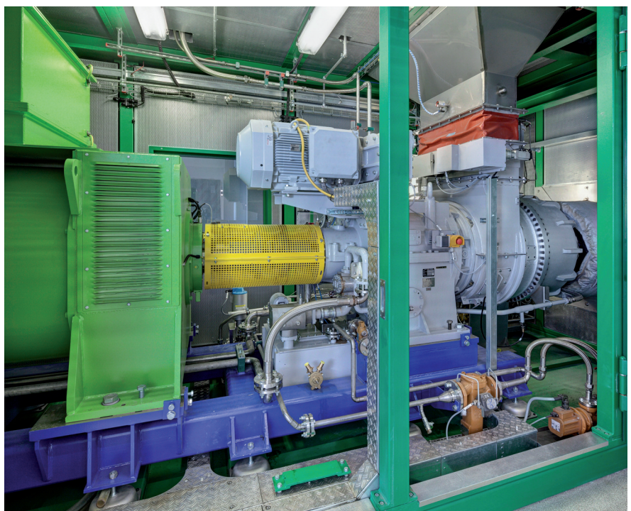
Nach ausführlichen Berechnungen des Ingenieurbüros stellte sich eine Gasturbine mit einer Leistung von 1,6 MW el als wirtschaftlichste Variante heraus. Diese deckt circa 82 % des Jahreswärmebedarfs.
