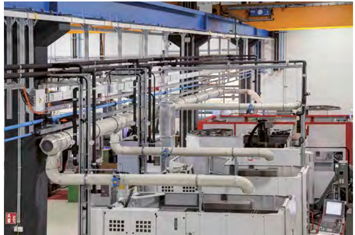
4 Dieses gewährleistet, dass in der Fertigung stets konstante Temperaturen von 20 °C herrschen, sodass eine Ausdehnung der Bauteile durch Temperatureinflüsse weitgehend vermieden werden kann.
